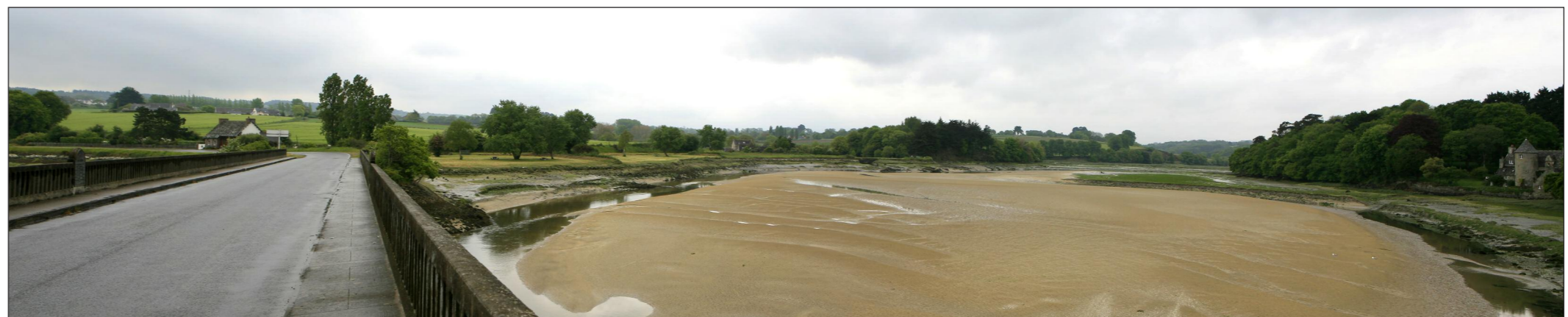
Vue du site avant projet
