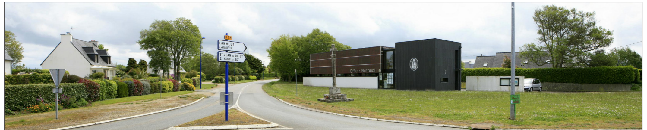
Vue du site avant projet
