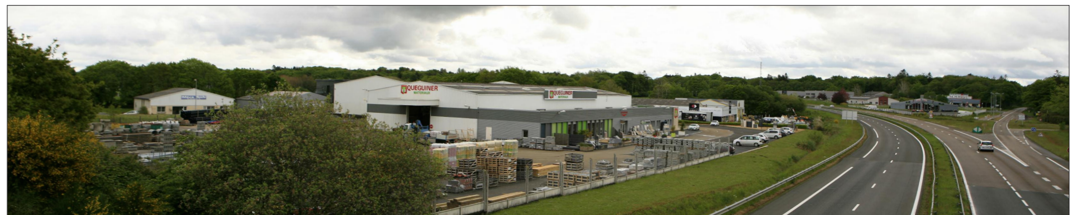
Vue du site avant projet
