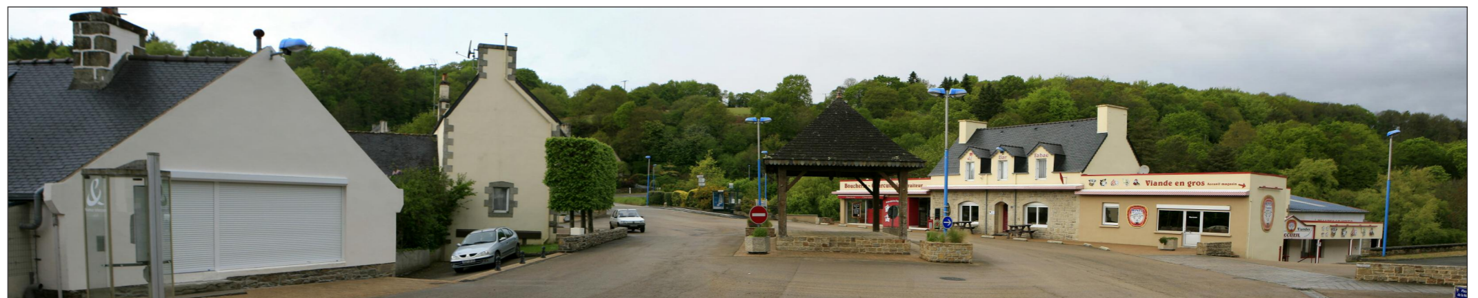
Vue du site avant projet
